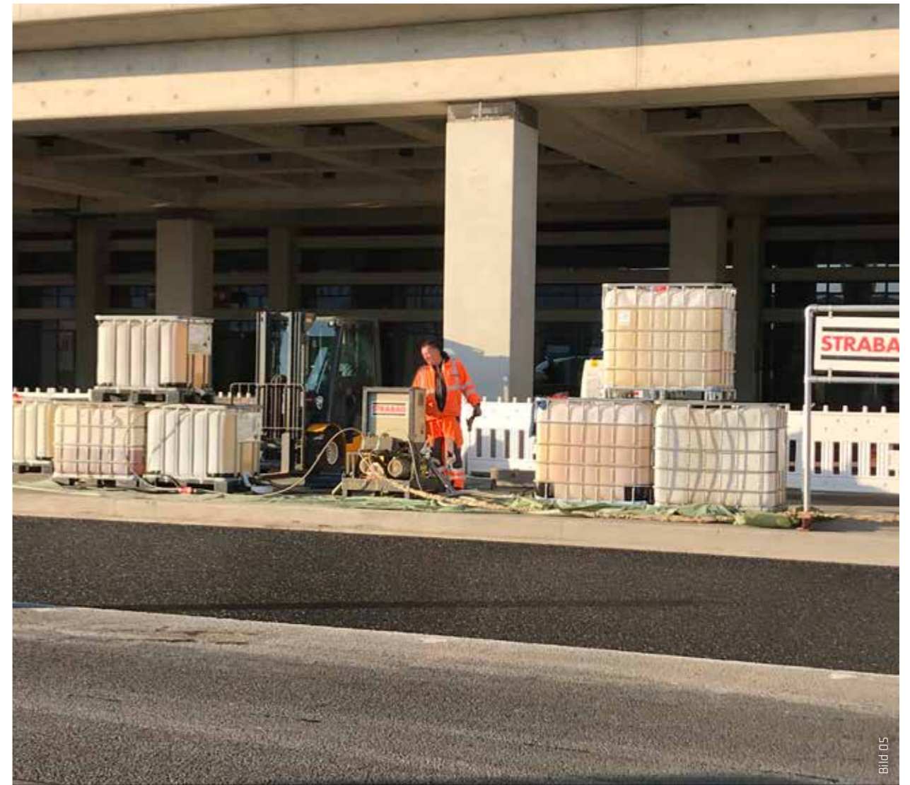
Am Straßenrand wurde die Zwei-Komponenten-Mischstation eingerichtet und Sika Ergodur®-1000 HANV drucklos auf der Asphalttragschicht aufgebracht.
