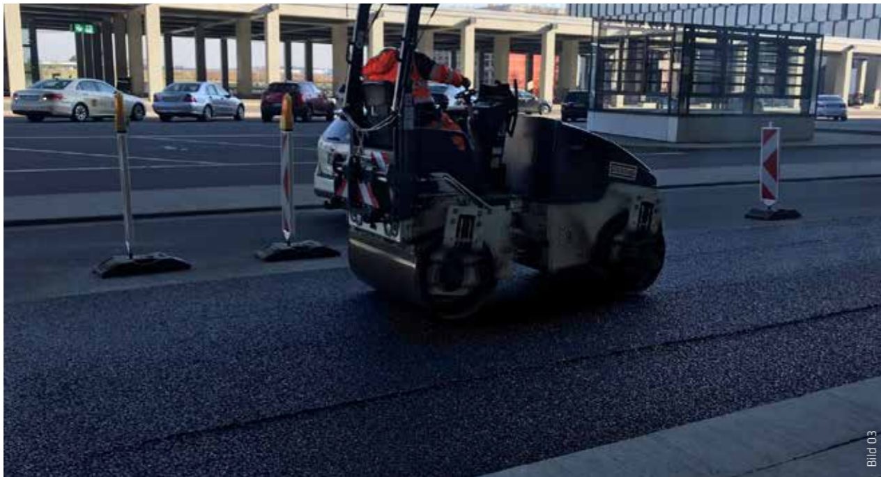
Um das Gefüge des Asphalttraggerüsts nicht zu zerstören, ist der Einsatz einer vibrationsfreien Walze für das Glätten der Oberfläche wichtig.
