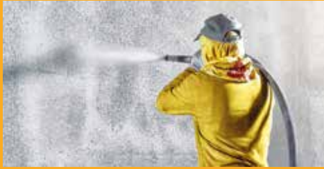
BETONSCHUTZ UND INSTANDHALTUNG
