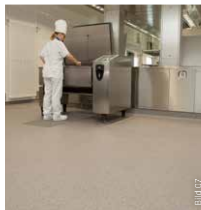
Blick auf die fertig ausgeführten Hohlkehlen. Die Ablaufrinnen wurden mit dem Mörtel SikaGrout®-558 untergossen.
