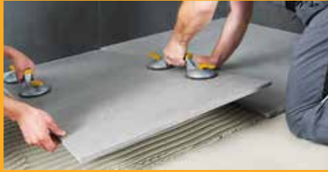
FLIESEN-, WAND- UND FUSSBODENTECHNIK
