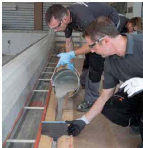
Verguss der kapillarbrechenden Fuge mit SCHÖNOX CON BODEN sowie SCHÖNOX Quarzsand 0,2 - 0,8 mm.
