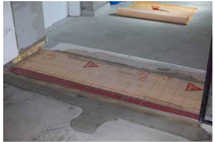
Der alte Boden wurde bis auf den Beton abgetragen und mit dem speziell für Nassbereiche geeigneten Schnellestrich SCHÖNOX SEB PLUS als Gefälleverbundestrich neu aufgebaut.
