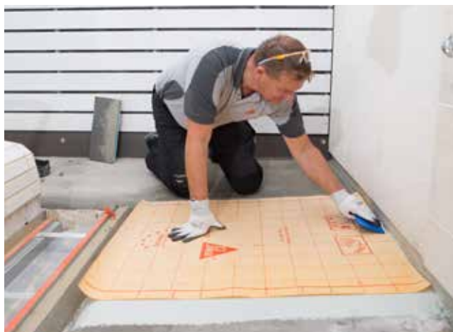
Die Abdichtung des Beckenumgangsbereichs erfolgte mit SCHÖNOX AB Bahnen. Die Baubeteiligten entschieden sich aufgrund der baulichen Gegebenheiten bewusst für diese pragmatische Sonderlösung. Die Verklebung von Bahnenüberlappung und Systemdichtband erfolgte mit SCHÖNOX iFIX.
