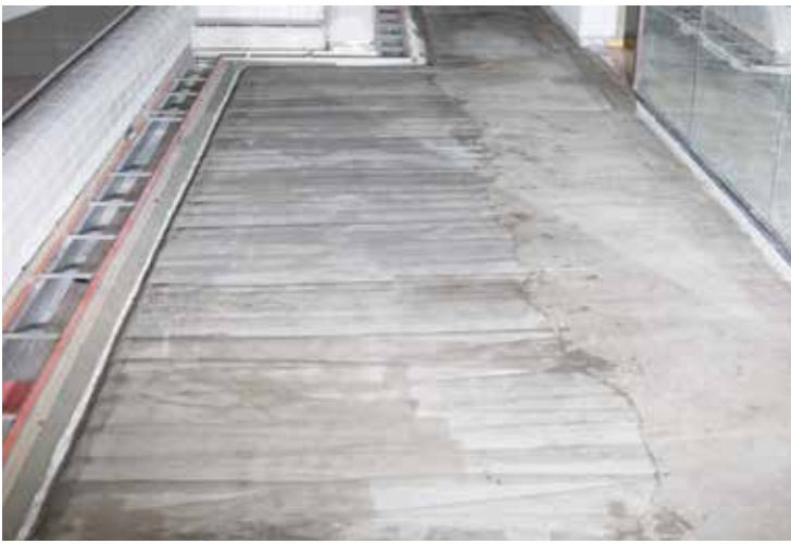
Der alte Boden wurde bis auf den Beton abgetragen und mit dem speziell für Nassbereiche geeigneten Schnellestrich SCHÖNOX SEB PLUS als Gefälleverbundestrich neu aufgebaut.
