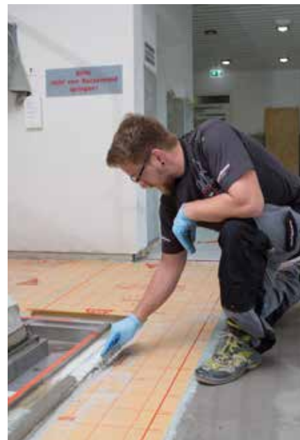
Die Verbundabdichtung wird mit dem Dichtkleber SCHÖNOX iFIX verklebt. Für eine fachgerechte Verarbeitung liefert der Hersteller die SCHÖNOX iFIX TOOLBOX, die Steckbügel, Roller, Schutzhandschuhe und Cuttermesser enthält.
