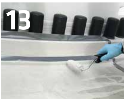
13 Fugenbereich mit Steinband PE Oberfläche abkleben. Rollvorlage mind. 0,5 - 0,7 kg/m 2
