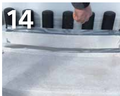
14 Einwurf Quarzsand 0,7 - 1,2 mm frisch in frisch, Korn an Korn. Klebeband Fugenbereich unmittelbar danach entfernen.
