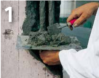
1 Prüfung Zustand Fundamentsockel ggf. Betoninstandsetzung.
