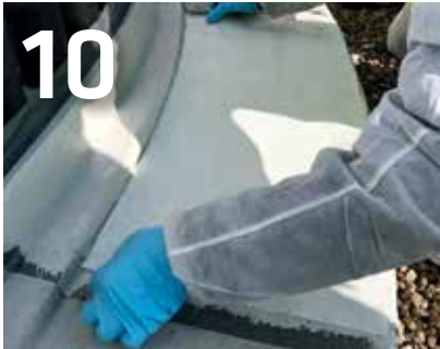
10 Vlies blasen- und faltenfrei einlaminiieren.
