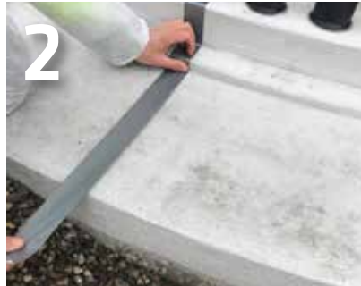
2 Abdichtenden Bereich ggf. mit Klebeband abgrenzen.
