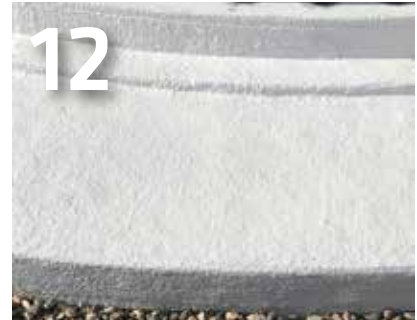
12 Nun ist die Abdichtung funktionsbereit.
