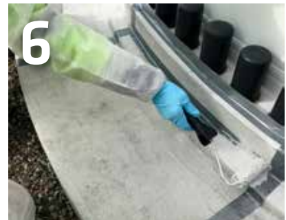
6 Grundierung gem. Verlegeanleitung Sikalastic vornehmen.
