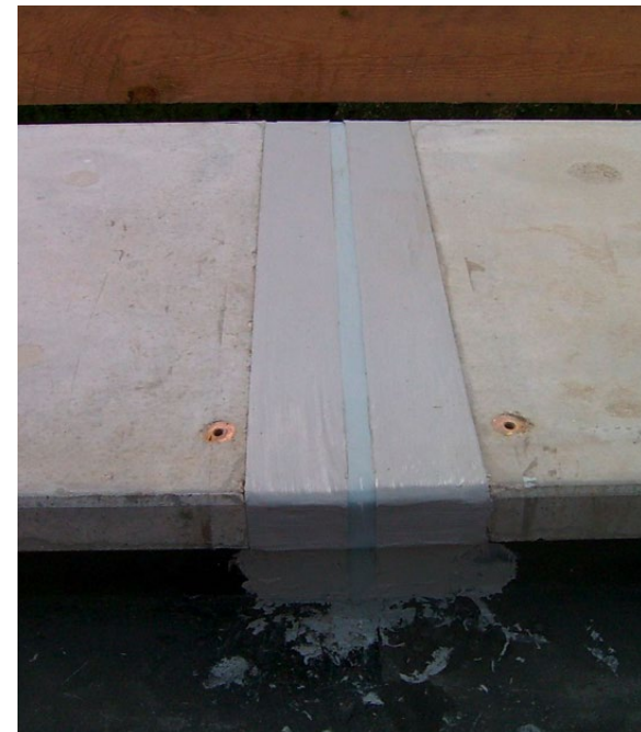
Ablebung von Raumfugen zwischen Betonfertigteil Randkappen mit Sikadur-Combiflex® TF Dichtstreifen
