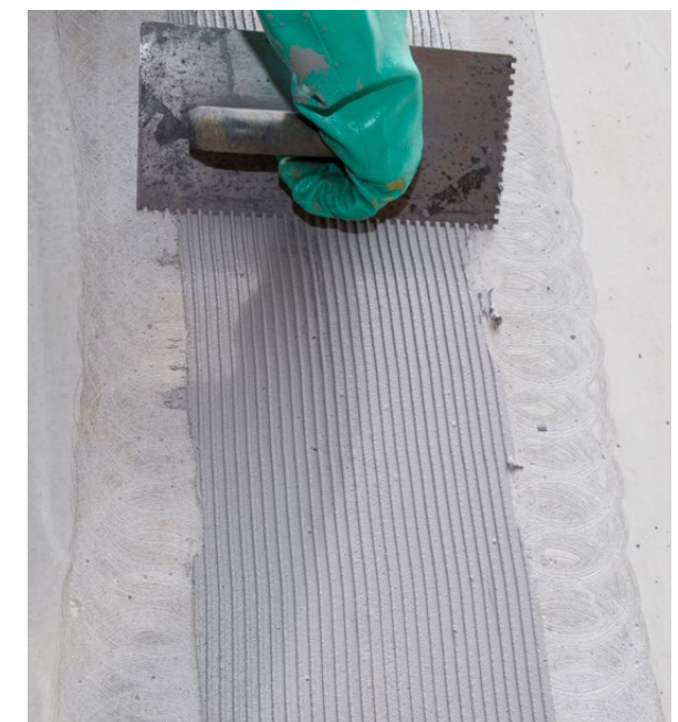
Ablebung von Raumfugen zwischen Beton-Fertigteilen einer Widerlager-Flügelwand mit Sikadur-Combiflex® TF Dichtstreifen
