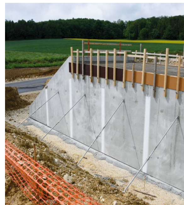
Ablebung von Raumfugen zwischen Beton-Fertigteilen einer Widerlager-Flügelwand mit Sikadur-Combiflex® TF Dichtstreifen
