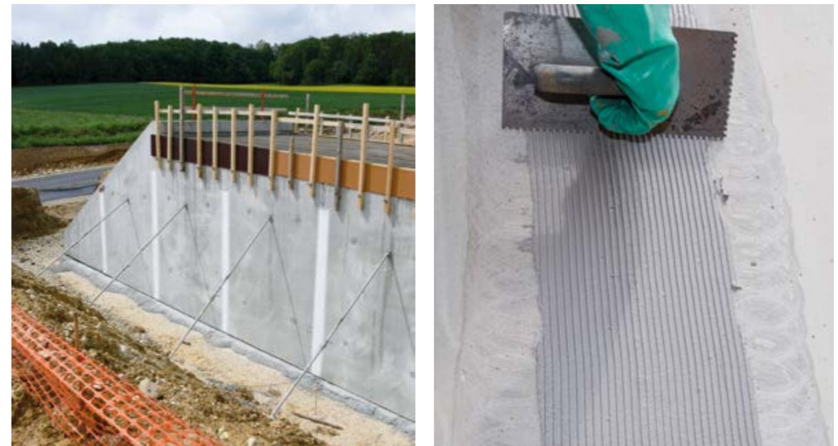
Ablebung von Raumfugen zwischen Beton-Fertigteilen einer Widerlager-Flügelwand mit Sikadur-Combiflex® TF Dichtstreifen
