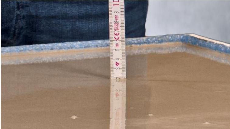
Das SCHÖNOX RENOTEX System schwimmend ist nach nur 12 Stunden bei einer Schichtstärke von 20 mm verlegereif, unabhängig von den klimatischen Bedingungen.
