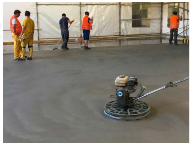
Applikation der Grundierung bereits 1,5 h nach Glättende (+20 °C)
