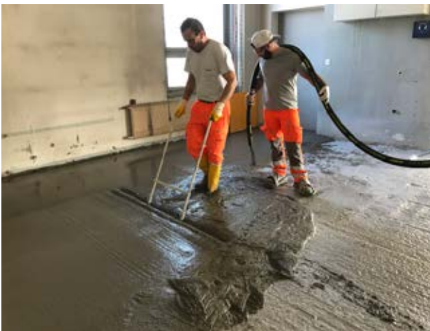
Körperschonende aufrechte Verarbeitung mittels Schwabbelstange Kein Abziehen mit einer Latte auf Knien mehr nötig
