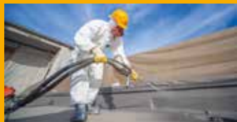
BETONSCHUTZ UND -INSTANDSETZUNG
