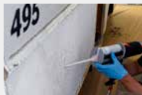
REPARATUR VON SANDWICHPANELS
