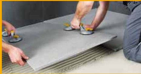
FLIESEN-, WAND- UND FUSSBODENTECHNIK
