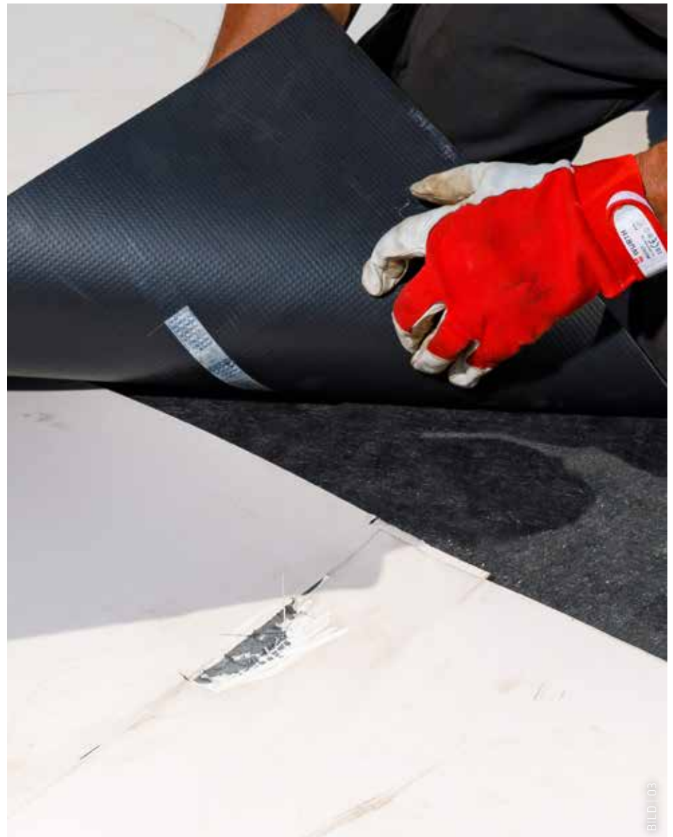
Unterhalb der Kunststoffabdichtungsbahn ist das zum Leckageortungssystem gehörende elektrisch leitende Glasvlies verlegt.
