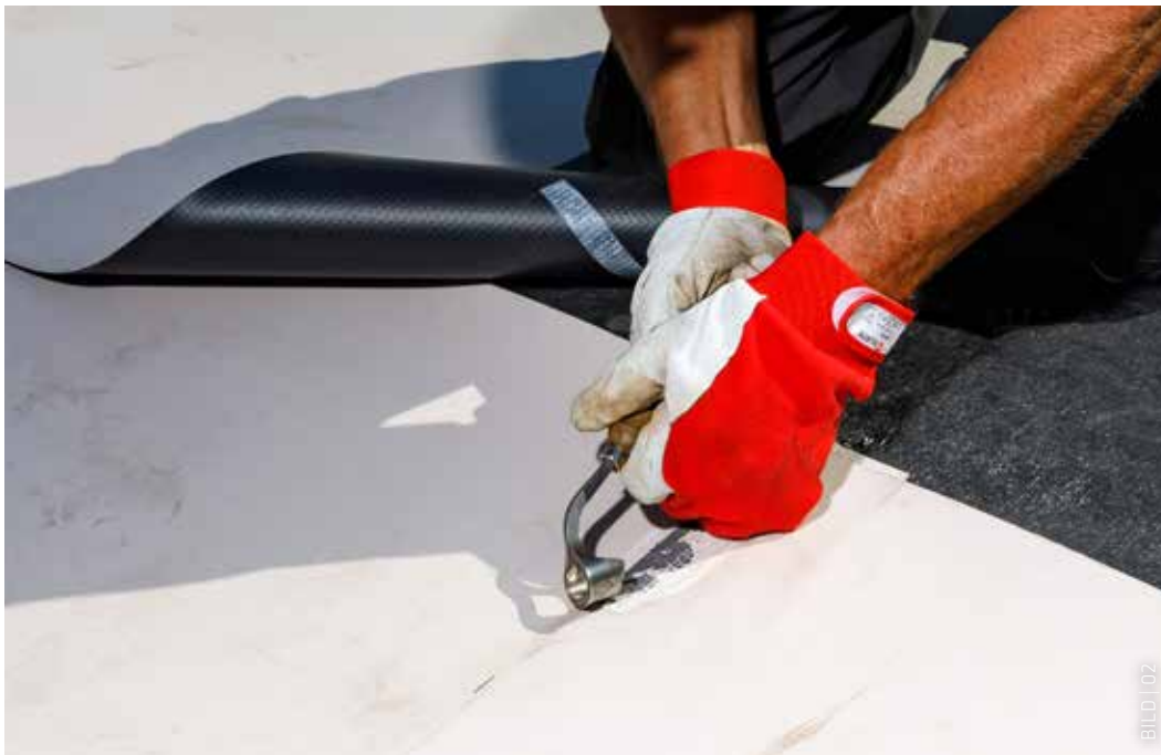
Die Kunststoffabdichtungsbahn wird im Bereich von T-Stößen gehobelt und handverschweißt.
