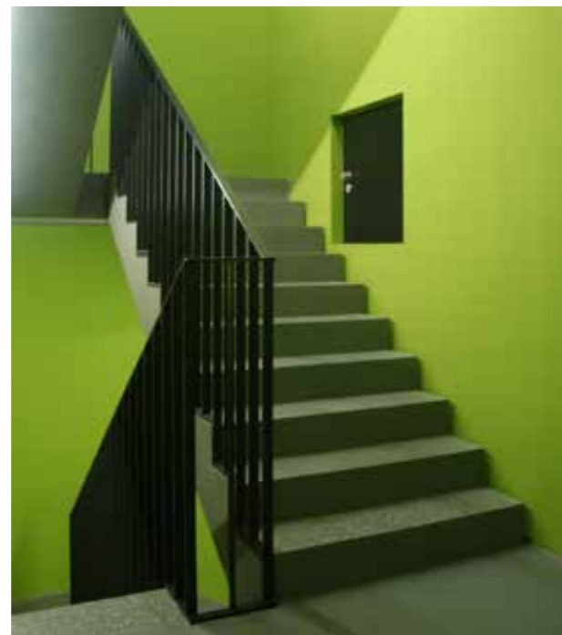
1. Grundierung: Sikafloor®-156 / -161 LO 2. Beschichtung: Sikafloor®-3240 3. Versiegelung: Sikafloor®-305 W
