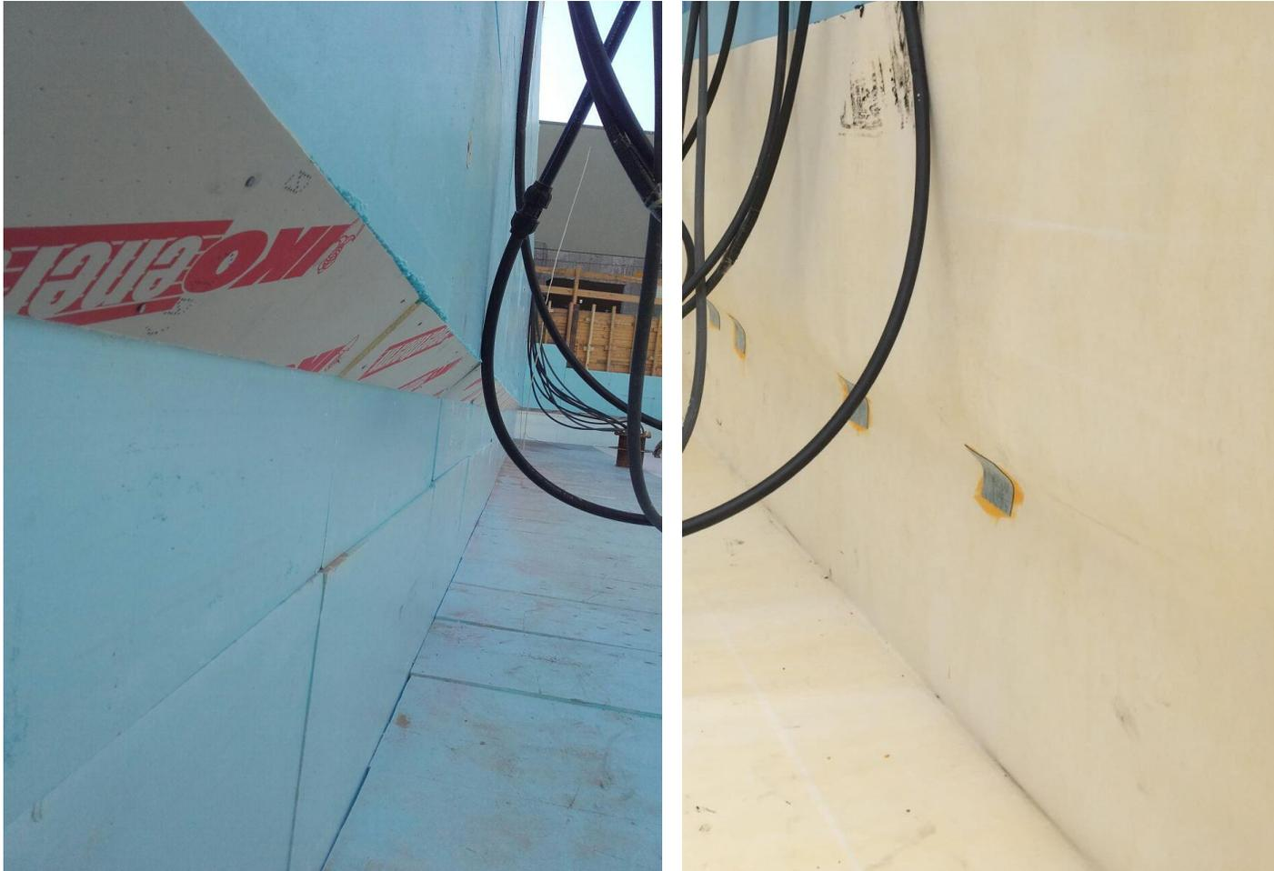
Rücksprünge durch Ausbildung von Keilen mit Perimeterdämmung abschrägen – somit ist eine hohlraumfreie Verfüllung ohne Betonierschatten (Hohlstellen) gewährleistet.
