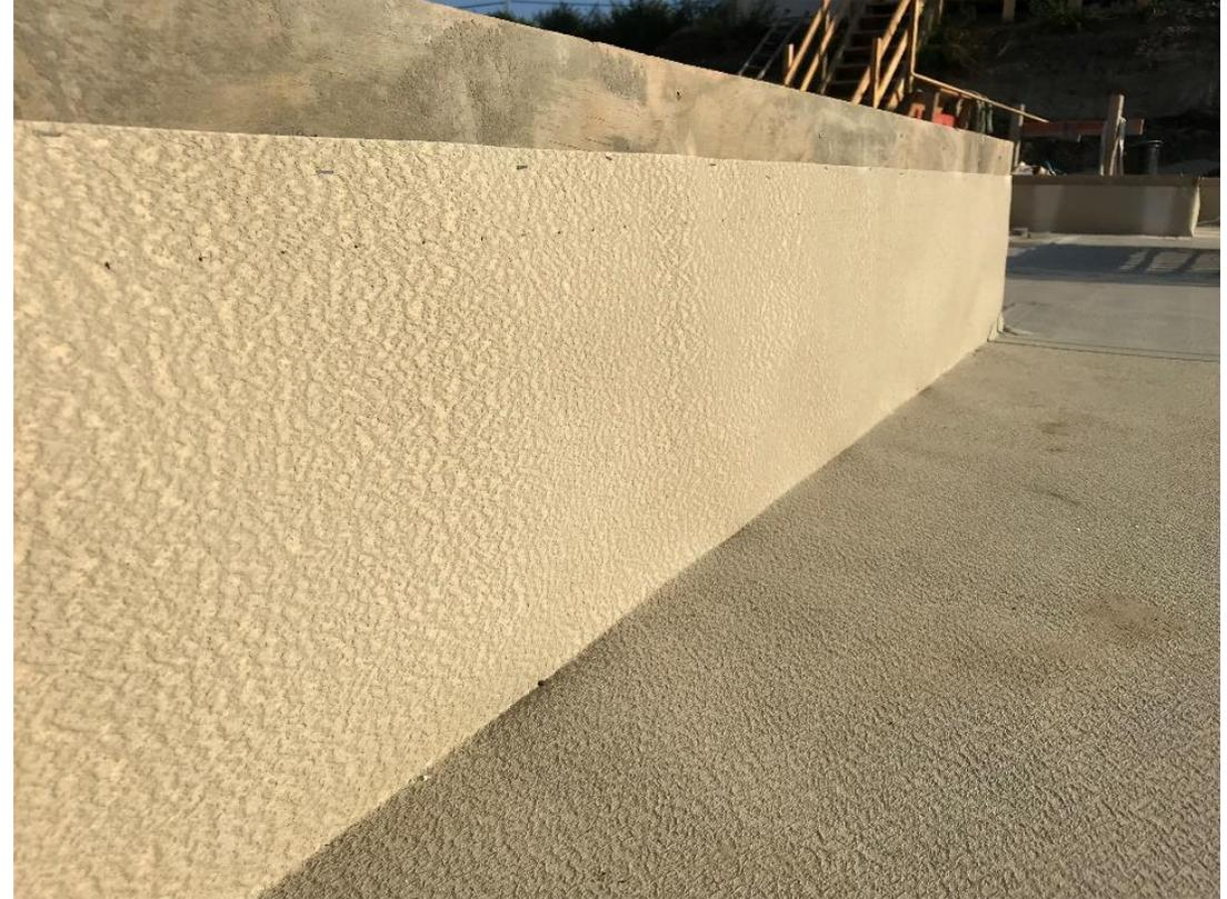
Spätere Ausbildung der Arbeitsfuge Bodenplatte-Wand berücksichtigen – entscheidet über die Verlegehöhe der Randaufkantung!
