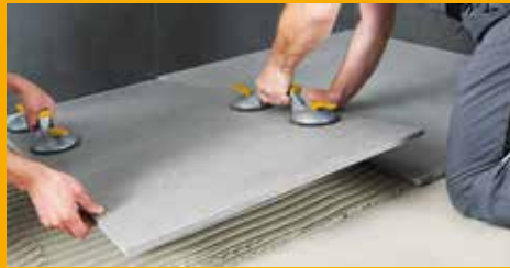
FLIESEN-, WAND- UND FUSSBODENTECHNIK
