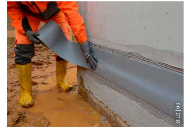
Abklebung der Boden-Wand-Fuge mit dem Sikadur-Combiflex® TF System.
