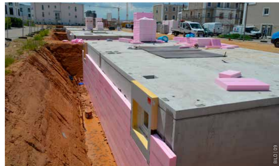
Bei der Wohnanlage im bayrischen Regensburg wurden mit dem Sikadur-Combiflex® TF System fünf Doppelhäuser mit Gebäudetrennfuge abgedichtet.
