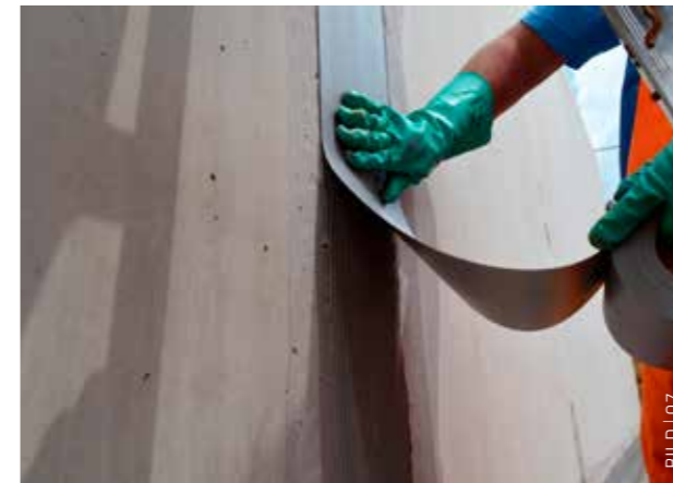
Einlegen des TPE-Dichtstreifens bei der Abklebung von Arbeitsfugen mit dem Sikadur-Combiflex® TF System.
