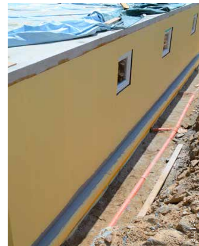
Kombinationsvariante: Vollständige Abdichtung eines Fertigteilkellers aus SikaProof® A+ im Bodenplattenbereich, SikaProof® P-12 im Wandbereich und Sikadur-Combiflex® TF System in der Boden-Wand-Fuge.
