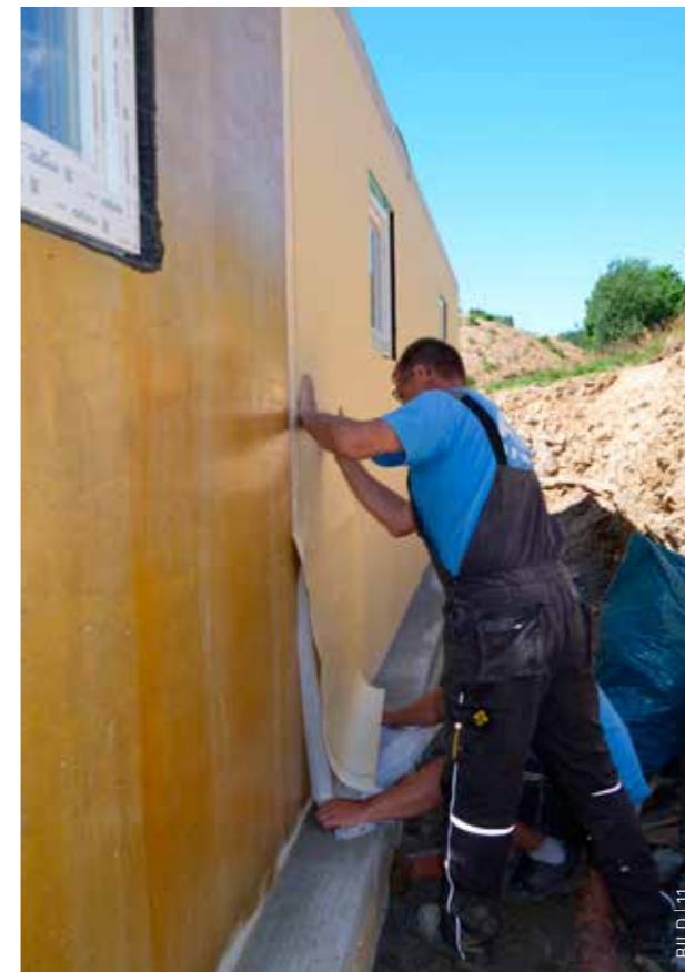
Applizieren der Fertigteilwandflächen mit dem SikaProof® P-12
