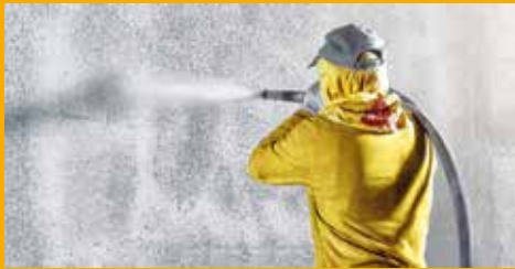
BETONSCHUTZ UND INSTANDHALTUNG
