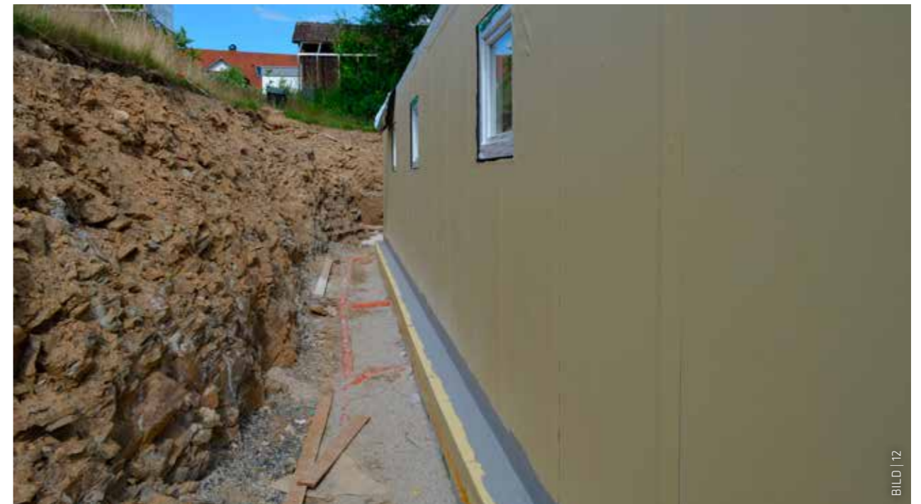
Fertige Abdichtung, bestehend aus SikaProof® A+ im Bodenplattenbereich, SikaProof® P-12 im Wandbereich und Sikadur-Combiflex® TF System in der Boden-Wand-Fuge.
