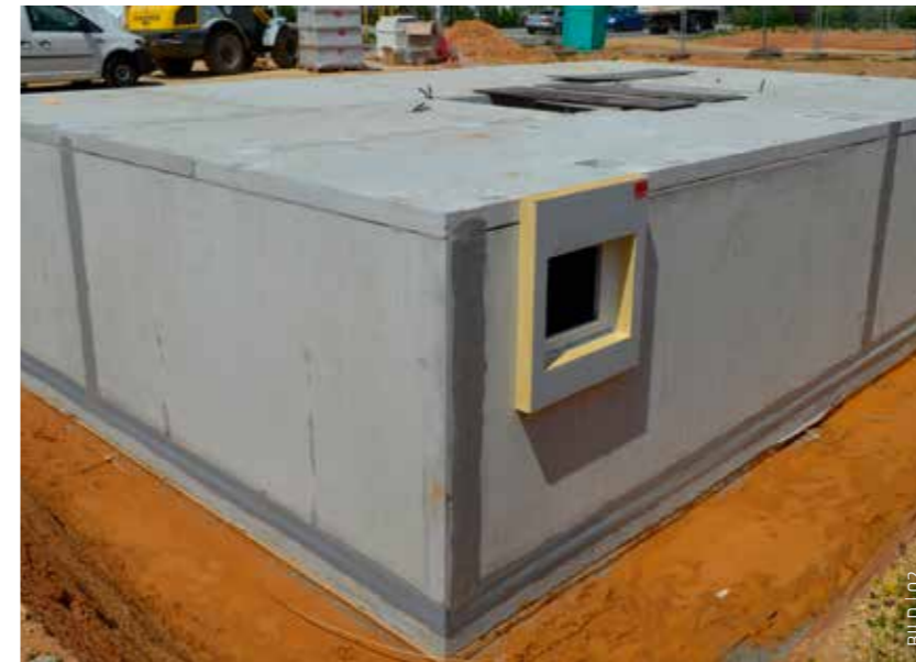
Fertigteilkeller der Fa. BFT Bayreuth GmbH, abgedichtet mit dem Sikadur-Combiflex® TF System.
