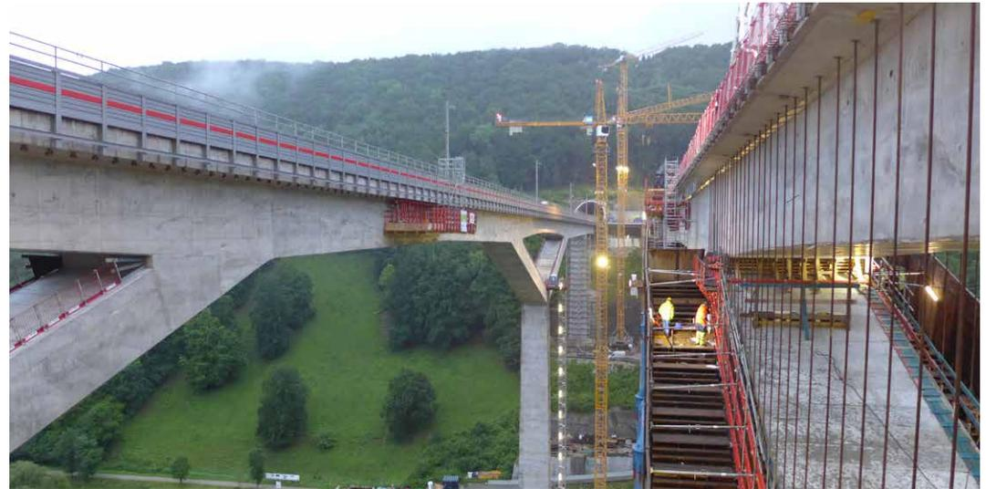
**Das Bauunternehmen Max Bögl realisierte das Vorhaben.** Dazu wurden die acht Anschlüsse der Y-Streben an den Überbau jeweils mit ca. 70 m<sup>3</sup> selbstverdichtendem Beton (SVB) vergossen und so starr verbunden. Der Beton musste dafür auf eine Höhe von 85 Metern und in der Horizontalen bis 120 Meter gepumpt werden. Weitere Vorgaben waren eine Verarbeitungszeit von 90 Minuten und die Gleichmäßigkeit des SVB bei den unterschiedlichen jahreszeitlichen Temperaturbedingungen.
