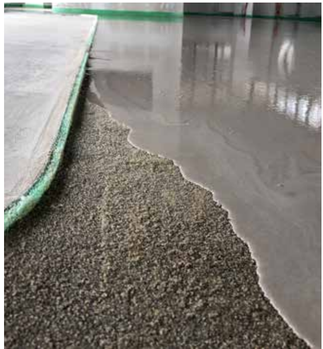
Verlauf von SCHÖNOX HS 50 auf der abgestreuten Grundierung Sikafloor®-150
