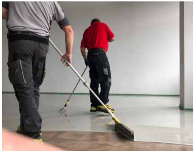
Aufziehen der Beschichtung Sikafloor®-3000 FX mit einer 48er Zahnung und anschließendes Strukturieren
