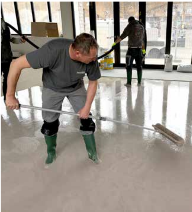
Applikation der Dickschichtspachtelmasse SCHÖNOX HS 50
