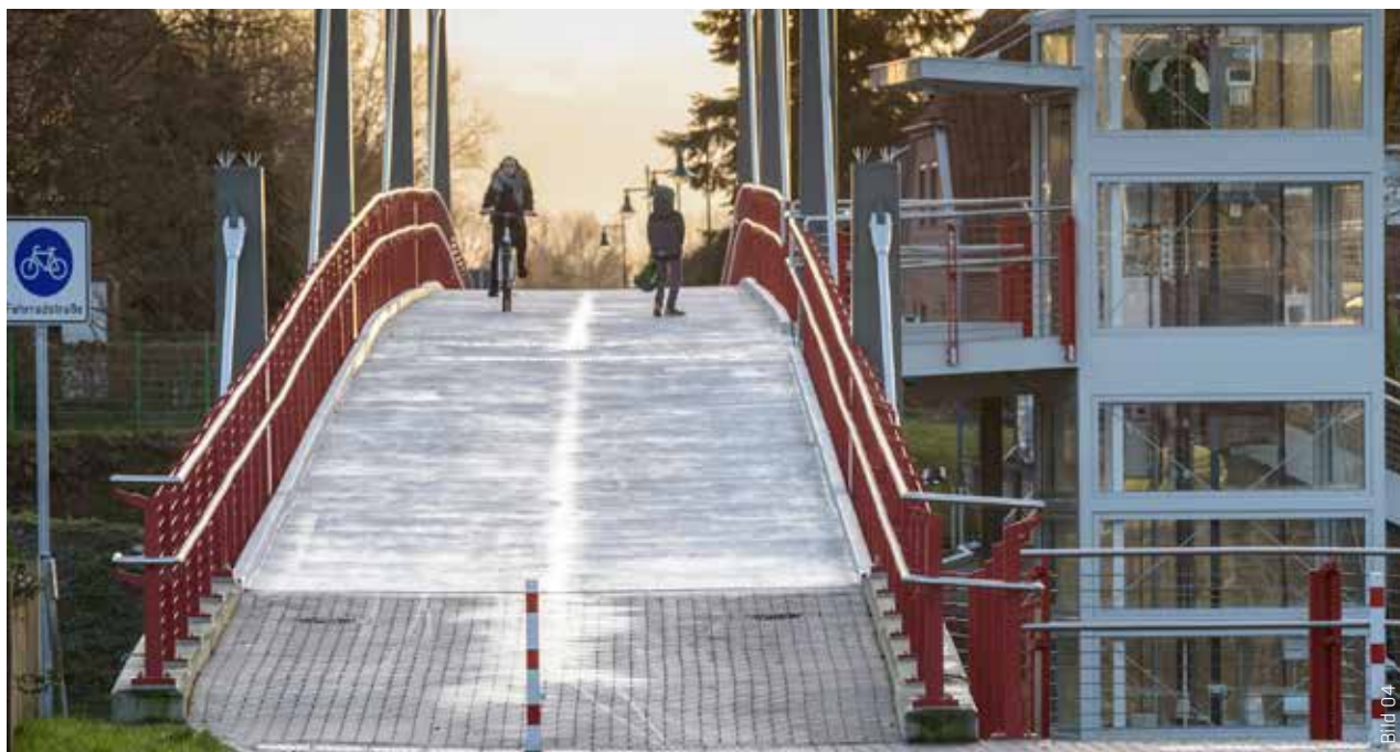
Die neue Brücke in Harsefeld wurde für Radfahrer und Fußgänger gebaut. Mit ihrer Breite von vier Metern bietet sie allen Verkehrsteilnehmern genügend Platz für eine komfortable und sichere Nutzung. Über eine Treppe und einen Aufzug ist die Brücke an den darunterliegenden Bahnhof mit P+R-Parkplatz angebunden.
