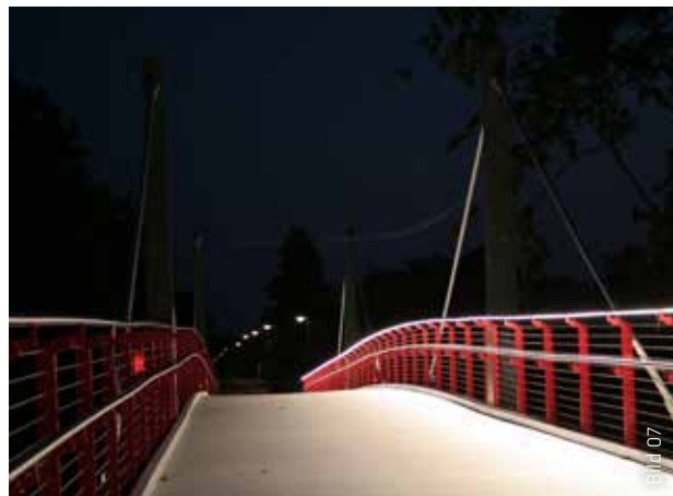
Die Beleuchtung der neuen Brücke in Harsefeld ist in die Handläufe integriert. Radfahrer und Fußgänger werden so bei Nacht nicht geblendet.
