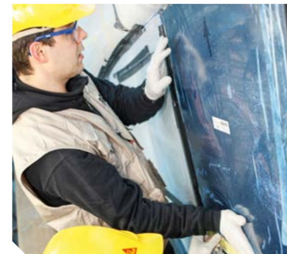
Die Scheibe kann direkt nach dem Fügen noch ausgerichtet werden
