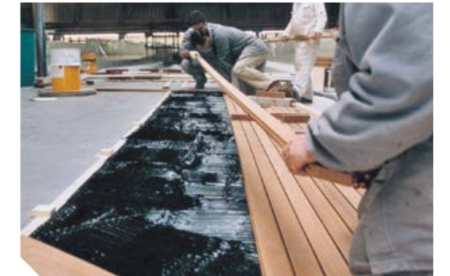
Aufbringen des Decks
