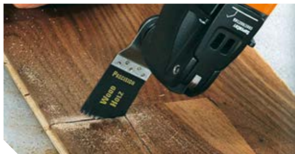
Trennen der Leisten mit einer Vibrationssäge
