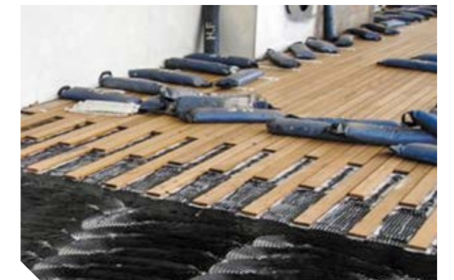
In Sikaflex®-298 eingebettete und mit Gewichten fixierte Teakleisten
