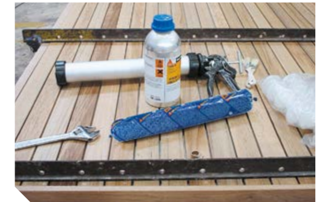
Stabdeck zur Aushärtung eingespannt
