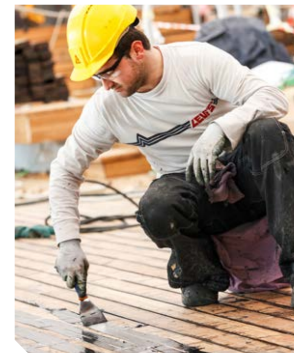
Sikaflex®-290 DC PRO mit einem Spachtel abziehen und einpressen
