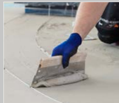
Der Reparaturmörtel ist auf Null ausziehbar.
