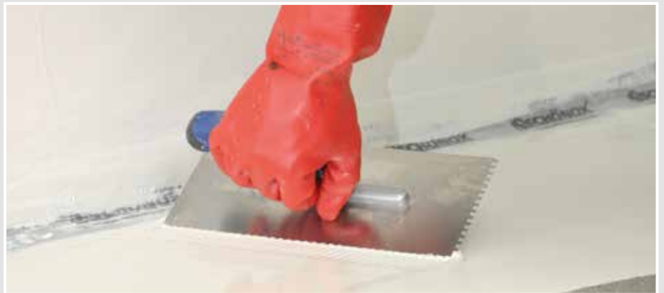
Die Polyurethan Abdichtung SCHÖNOX EA PUR mit einer 6er Zahnung aufbringen.
