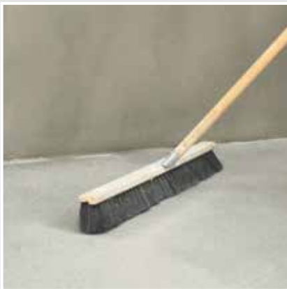
Absaugen/abkehren des überschüssigen Quarzsandes auf der durchgetrockneten Fläche.
