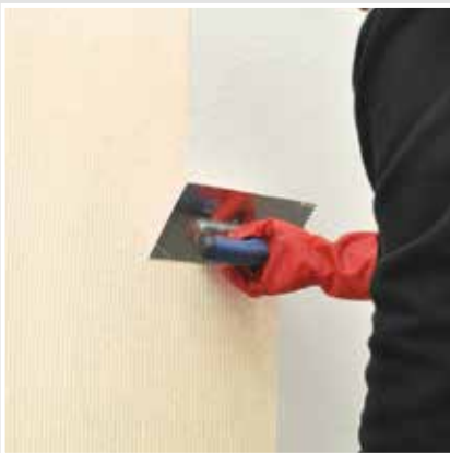
Die Polyurethan Abdichtung SCHÖNOX EA PUR S mit einer 4er Zahnung aufbringen.
