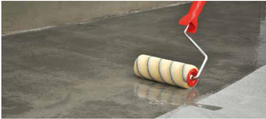
Die Grundierung SCHÖNOX GEA mit einer Kurzflorrolle aufbringen.
