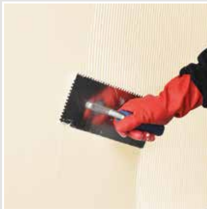
Die aufgebrauchte Material mit einer Kelle abglätten und die Schichtdicke prüfen.
