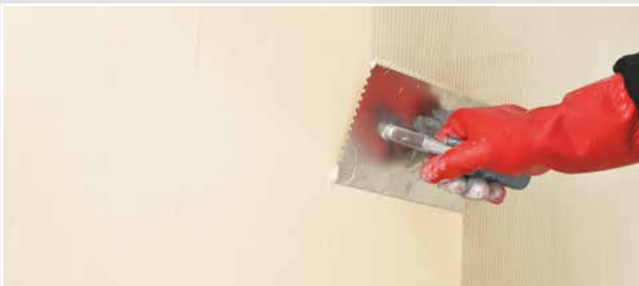
Auch die 2. Schicht SCHÖNOX EA PUR S mit einer Kelle abglätten und die Schichtdicke prüfen.
