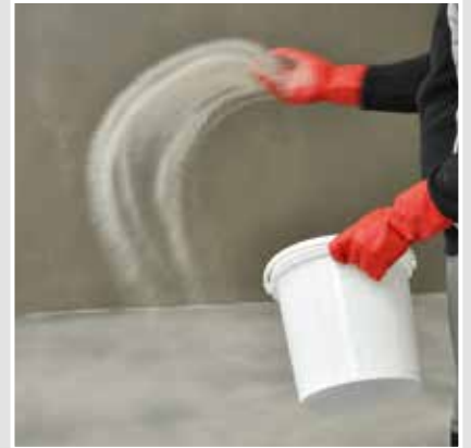
Die grundierte Fläche mit feuergetrocknetem Quarzsand (0,2 - 0,8 mm) absanden.
