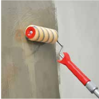
Die Grundierung SCHÖNOX GEA mit einer Kurzflorrolle aufbringen.
