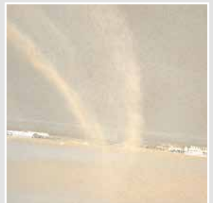
Die Fläche in der Frischphase des Material mit Quarzsand absanden und nach Trocknung absaugen/abkehren.
