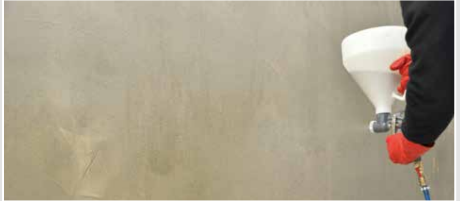
Die grundierte Fläche mittels Trichterpistole mit feuergetrocknetem Quarzsand (0,2 - 0,8 mm) absanden.
